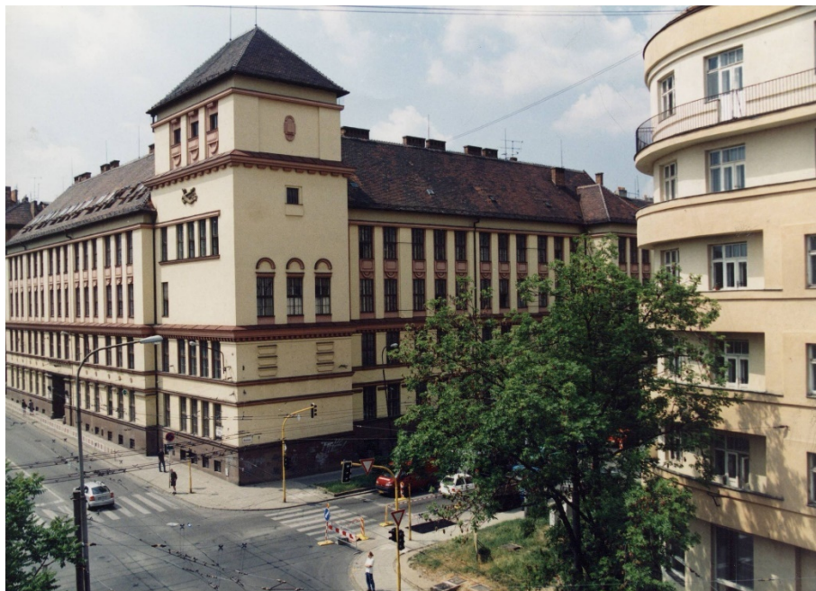
Rohová budova Státní jazykové školy s právem státní jazykové zkoušky, Brno, Kotlářská 9
